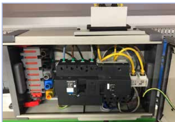
Fig 10. connecteur débrochable Socomec - intégration dans coffret de dérivation
