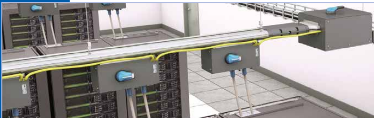
Fig 12. Inter connection DIRIS Digiware de coffrets de dérivation
